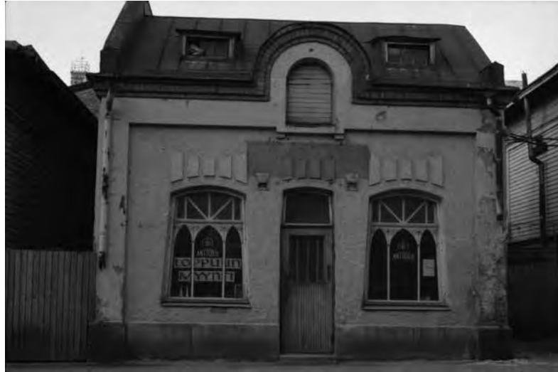
Yllä: Aleksanterinkadun Saunarakennuksen uusittu jugend-julkisivu kuvattuna vuonna 1977. August Brander 1904. Aleksanterinkatu 21, tontti nro 562(21) (Tampereen Museot TM).
